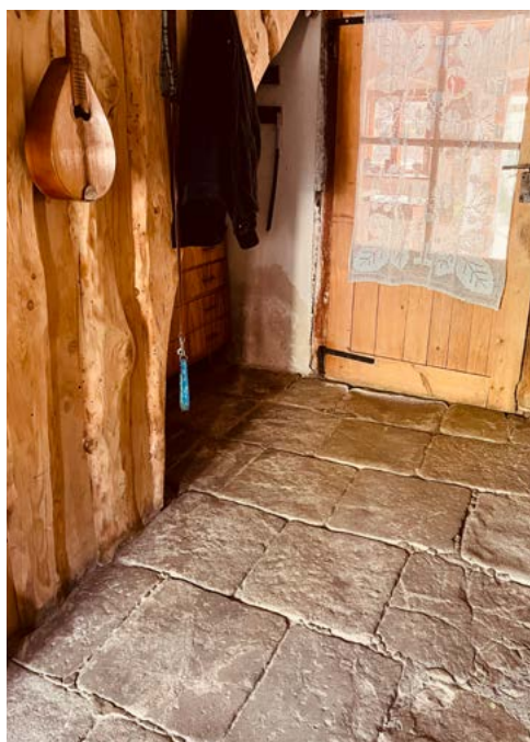
ryc. 11 Wszelkie niedoskonałości tej kamiennej podłogi świadczą o jej wieku i dodają jej autentyczności. Poza bieżącym utrzymaniem ta podłoga nie wymaga żadnych ingerencji
