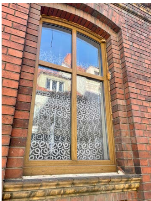
ryc. 5 Ta sama kamienica, okno po wymianie nieprzystosowane formą i kolorem do oryginalnej stolarki
