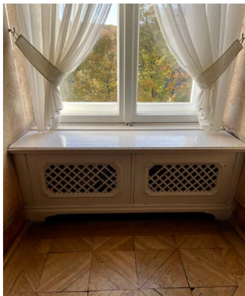
ryc. 10 Obudowy grzejnika miały na celu zmniejszenie ich widoczności w zabytkowych wnętrzach. Zamek Książ, Wałbrzych, Dolny Śląsk
