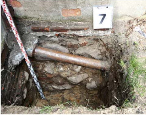
ryc. 1 Fundament z kamieni polnych zabezpieczonych przed wilgocią warstwą gliny
