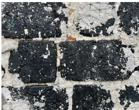
ryc. 12, 13 Budynek i ściany wzniesione z bloków produkowanych z odpadów hutniczych
