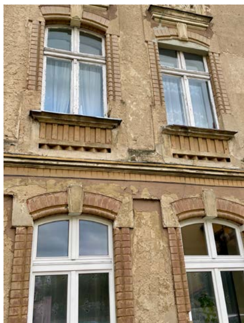
ryc. 2 Elewacja zabytkowej kamienicy z częściowo zachowanymi oryginalnymi oknami i częściowo wymienionymi na okna z pvc
