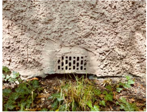
ryc. 3 Kratka wentylacyjna dla podłogi na stopie wentylowanym
