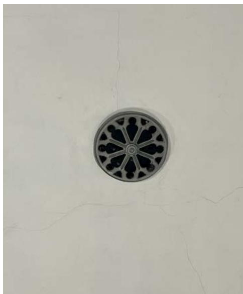
ryc. 5 Niedrożne otwory wentylacyjne w stopniu kościoła
