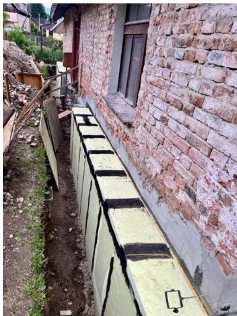
ryc. 12 Zastosowanie inwazyjnej metody „osuszania” i termoizolacji ściany fundamentowej
