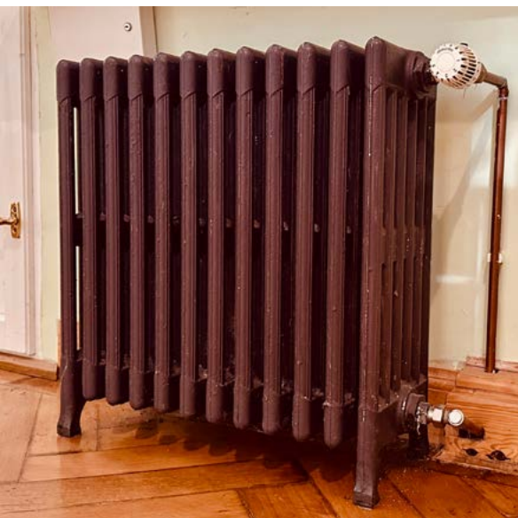
ryc. 8 Grzejnik żeliwny, druga połowa XIX w. Muzeum Dom Hauptmanna, Jagniątków, Dolny Śląsk
