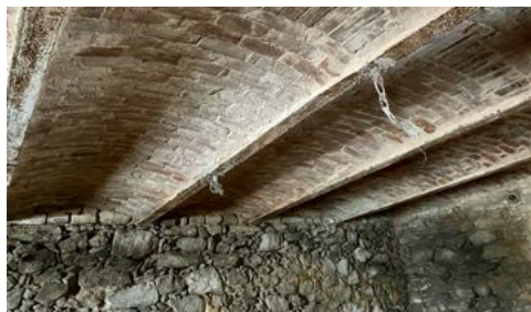
ryc. 4 Typowy strop murowany odcinkowy w części gospodarczej budynku wiejskiego, w części mieszkalnej znajdują się stropy drewniane
