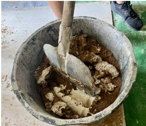
ryc. 11 Mieszanie ręczne szpadłem
