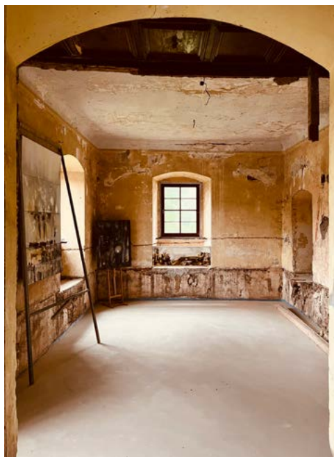
ryc. 8 W budynku znajdowały się stropy drewniane i podłogi z desek na legarach. Wylanie betonowych posadzek wymaga wzmocnienia stropu i ścian
