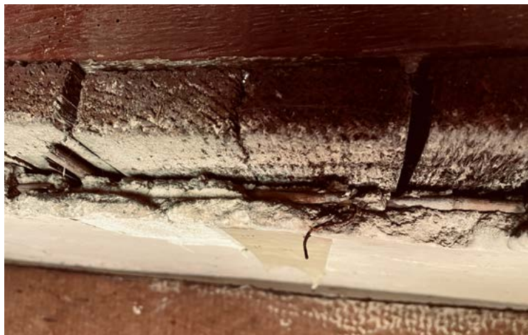
ryc. 7 Przekrój przez warstwy sufitu: deski, mata trzciniowa mocowana drucikami, tynk piaskowo-wapienny
