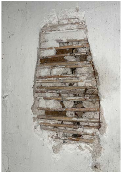
ryc. 8 Tynki wapienne na ścianie na podkładzie z maty trzcinowej. Widoczna jest pierwsza warstwa wciśnięta między żdźbła trzciny
