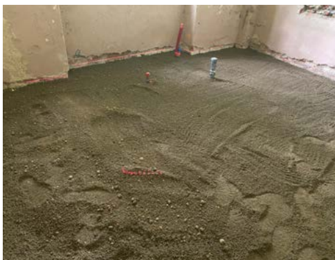
ryc. 14 Postęp w usypywaniu posadzki wapiennej
