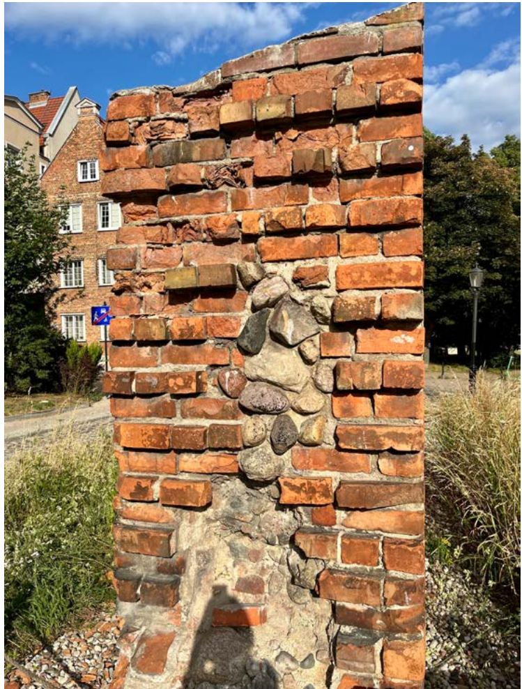
ryc. 1 Przekrój muru ceglanego
