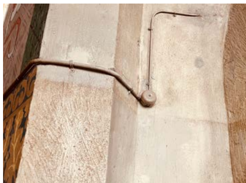
ryc. 4 Przykład instalacji natynkowej. Albrechtsburg, Miśnia, Saksonia
