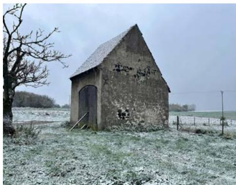
ryc. 12, 13 Budynek i ściany wzniesione z bloków produkowanych z odpadów hutniczych
