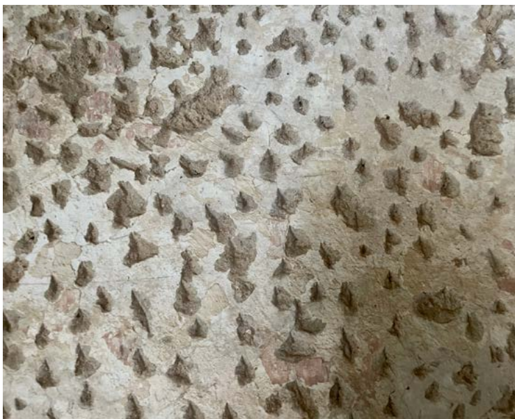
ryc. 4 Przykład nasiekania tynków historycznych – ta powierzchnia była przygotowana do nałożenia nowej warstwy tynku
