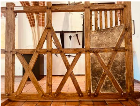
ryc. 7 Etapy konstrukcji ściany drewnianej szkieletowej ryglowej. Muzeum Regionalne w Jaworze, Dolny Śląsk
