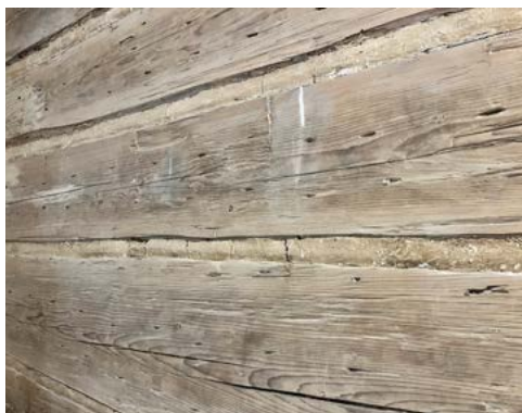
ryc. 17 Ściana drewniana zrębowa, w której przerwy między belkami zostały zaizolowane gliną. Na belkach widać ślady po konstrukcji przygotowującej ścianę dodatkowo do obrzucenia tynkiem. Wieża Książęca w Siedlęcinie, Dolny Śląsk
