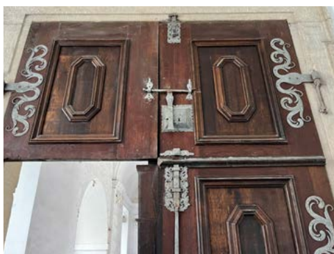
ryc. 7 Zachowane okucia okienne stanowią dziedzictwo technologiczne i wpływają na ogólny odbiór okna
