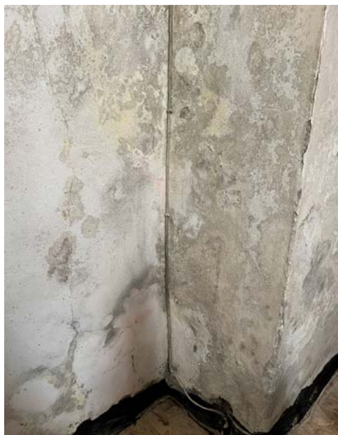
ryc. 9 Współczesna bitumiczna izolacja pionowa zastosowana w tradycyjnym budynku murowanym i degradacja tynków na skutek migracji wody w kapilarach, której odcięto swobodnego odparowania
