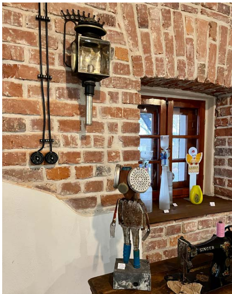
ryc. 5 Współczesna instalacja natynkowa stylizowana na historyczną. Galeria Versus, Grodziec, Dolny Śląsk
