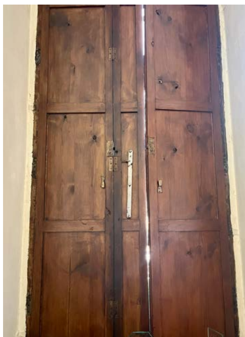
ryc. 11 Okiennice wewnętrzne w pozycji zamkniętej
