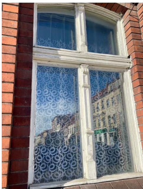
ryc. 4 Oryginalne okno w kamienicy przyrynkowej
