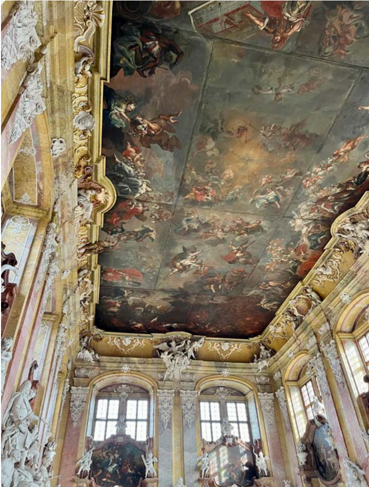
ryc. 6 Przykład bogato dekorowanego sklepienia zwierciadlanego. Zespół pałacowo-klasztorny w Lubiążu, Dolny Śląsk
