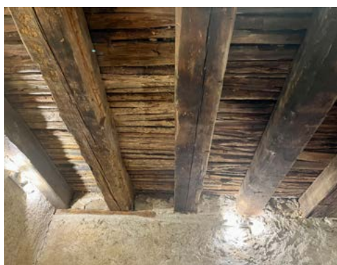
ryc. 4 Najprostsza konstrukcja stropu drewnianego. Wieża Książęca w Siedlęcinie, Dolny Śląsk
