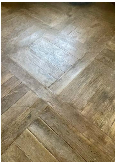
ryc. 12 Zabytkowy parkiet drewniany po dokładnym odkurzeniu, umyciu przy użyciu delikatnego rozpuszczalnika, nałożeniu dwóch warstw wosku pszczelego rozpuszczonego w naturalnej terpentynie i wypolerowaniu filcową ściereczką. Niczego więcej nie potrzeba, aby zachować jego charakter, a już na pewno nie cyklinowania
