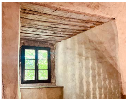
ryc. 16 Konstrukcje murowane z cegieł mają wysoką masę termiczną i nie jest konieczna ich izolacja, zwłaszcza za pomocą materiałów syntetycznych. Wieża Książęca w Siedlęcinie, Dolny Śląsk
