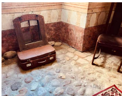
ryc. 2 Jeden z najprostszych sposobów na wykonanie podłogi -- klepisko z kamieniami polnymi. Pałac Gorzanów, Dolny Śląsk
