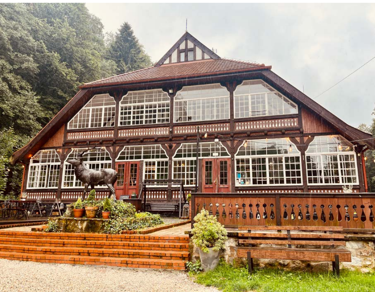
ryc. 1 Bywa, że okna dominują cały wystrój elewacji. Pensjonat Złoty Jar, Dolny Śląsk
