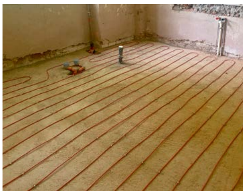
ryc. 17 Układanie instalacji ogrzewania podłogowego na wylewce wapiennej
