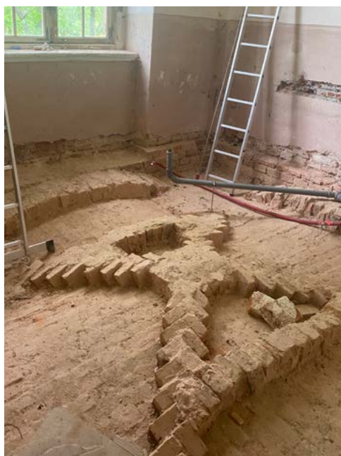
ryc. 13 Usunięcie zasypiska ze stropu sklepionego. Na tym etapie konieczny jest przegląd stanu stropu i ewentualne uzupełnienie spoin (w tym od spodu)
