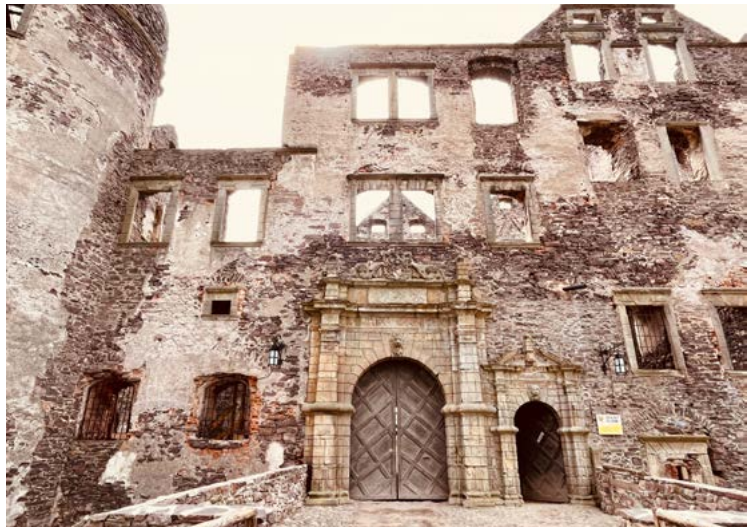
ryc. 6 Tynkowanie stanowi ochronę lica kamiennego muru i było praktykowane także w przypadku budowli monumentalnych, typu zamki. Zamek Świny, Dolny Śląsk
