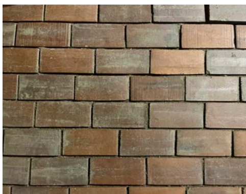
ryc. 3 Podłoga z cegieł na podsypce
