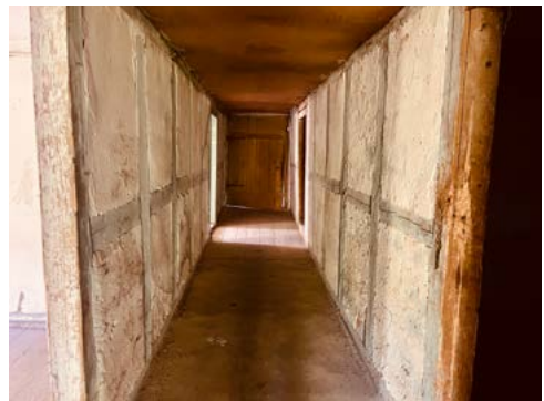
ryc. 8 Przykład bielenia ściany szkieletowej w całości, także z elementami drewnianymi
