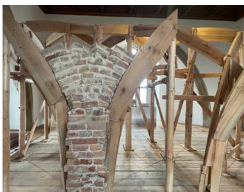
ryc. 5 Murowanie sklepienia przy pomocy drewnianego rusztowania z krążynami
